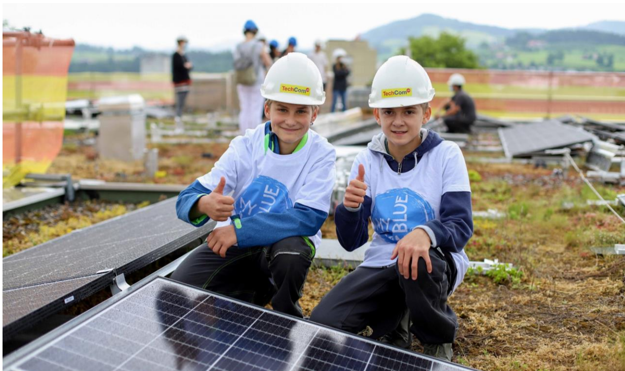
Am «Impact Day Solarenergie» durften ausgewählte Schüler:innen bei der Montage der neuen Solaranlage auf dem Schuldach mithelfen.
